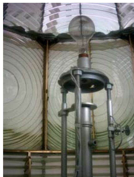
Fig. 27. Lentes de Fresnel del faro de la Paloma. (Gentileza de la Prof. Gabriela Baccino).
